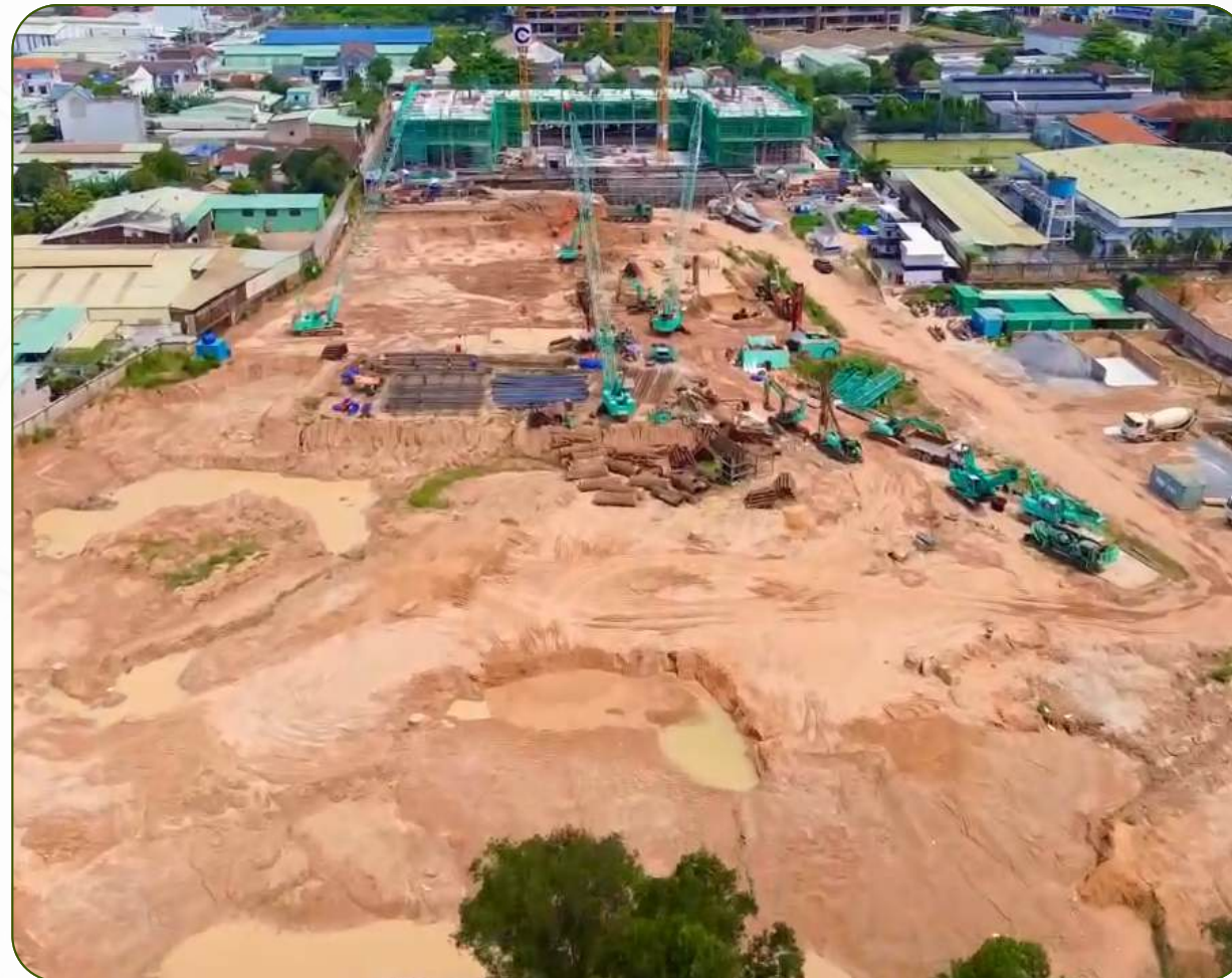
Cập nhật tiến độ ngày 24.04.2025: Thi công cọc
