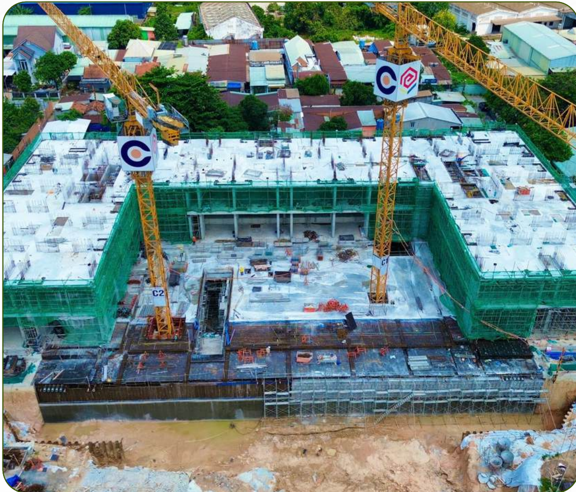
Công trường dự án
